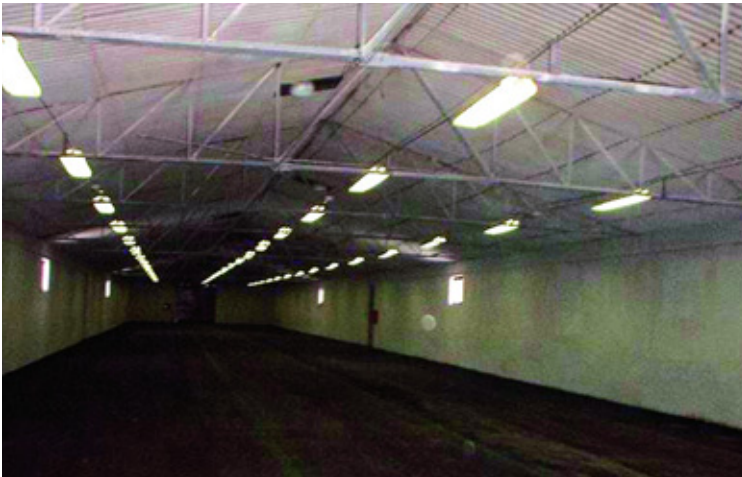
Skladiščni prostori v Beogradu po zaključku obnove.
