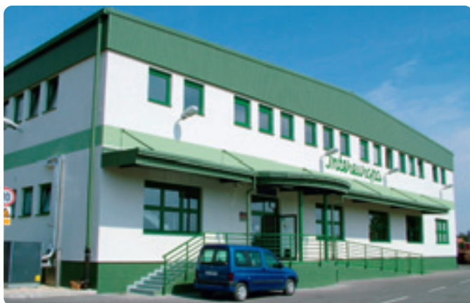
V kratkem pričakujemo vsa potrebna dovoljenja tudi za skladišče ADR.
