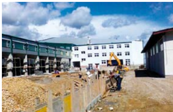
Logistični center v Samoborju v gradnji
