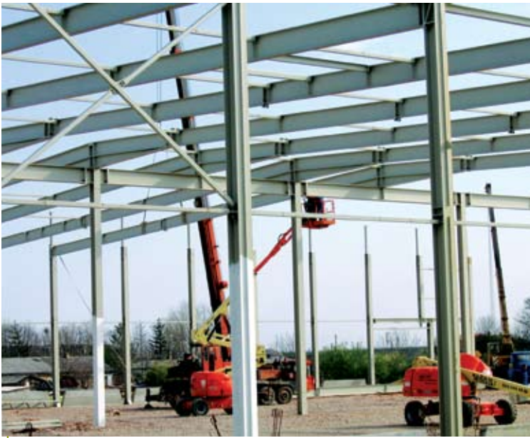
Gradnja novega logističnega centra.
