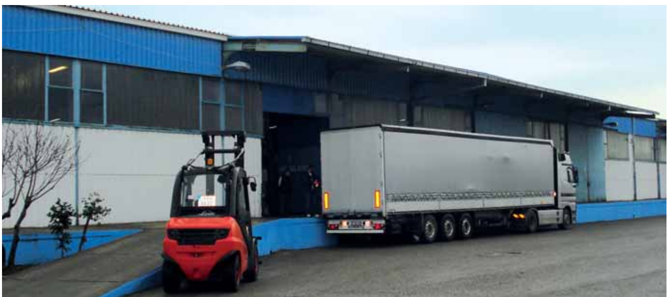
↓ Skladiščne zmogljivosti v Podgorici zajemajo tudi hladilnice za temperaturne režime do -20°C in nulti režim (na sliki), ter podzemne rezervoarje za gorivo zmogljivosti 2 milijona litrov.
